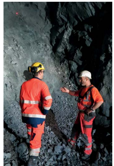
Bild 4. Der Polier schlägt dem Bauleiter eine Vereinfachung der Ortsbrustsicherung vor.
